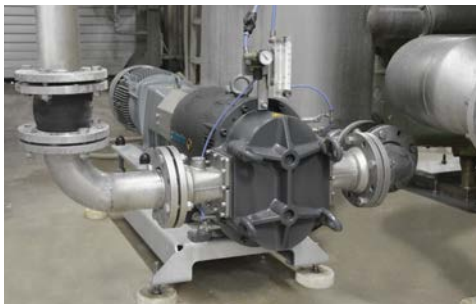
Bomba ONIXline para transportar lechada de almidón
